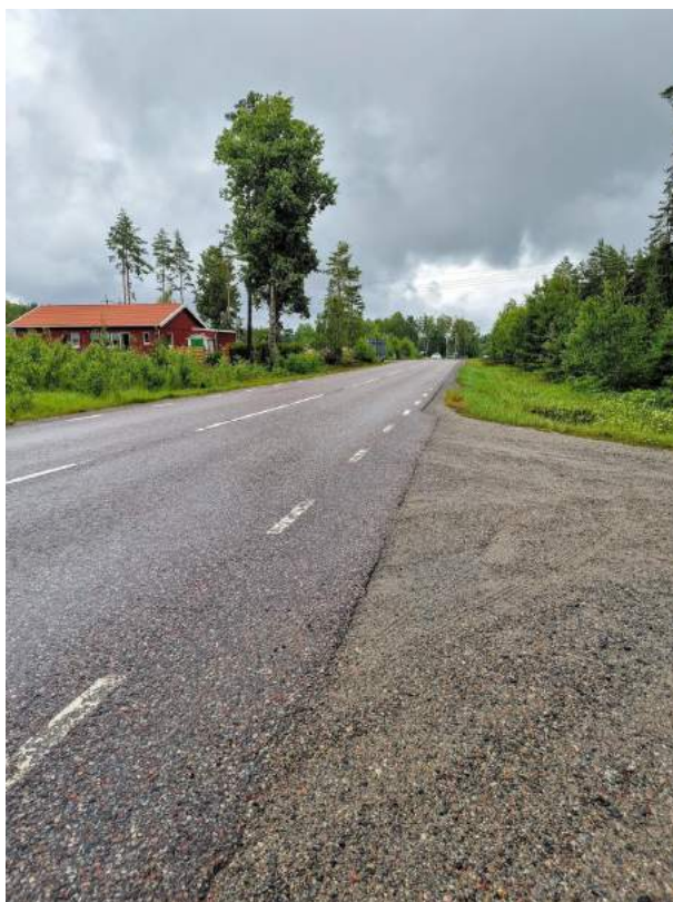
Bild 4: Till vänster är ett av husen i Norr Enby. Till vänster på Sorundavägen, väg 542, syns det att sikten är dålig i backen, särskilt om ett tungt fordon med släp ska hinna svänga vänster från utfarten till det tänkta verksamhetsområdet, som syns till höger i bild.
