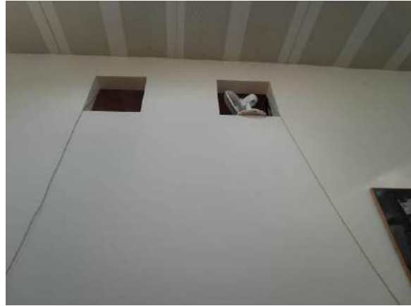
Bild 17. Ventilation till loftet i lärar-rummet.
