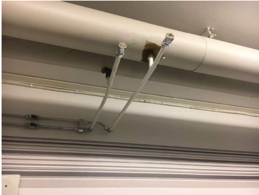
Bild 2: Proppade avstick som ej följer krav enligt Säker vatten.
